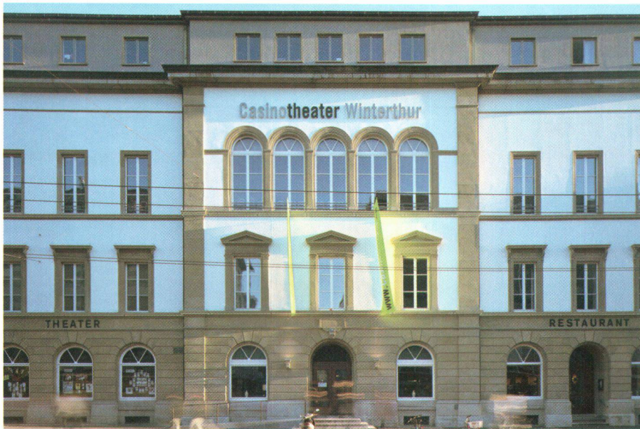
Hauptfassade des Casinotheaters Winterthur im Neu-Renaissance-Stil und dem in den 1930er Jahren aufgesetzten Dachstock (Bild W. Mair)
