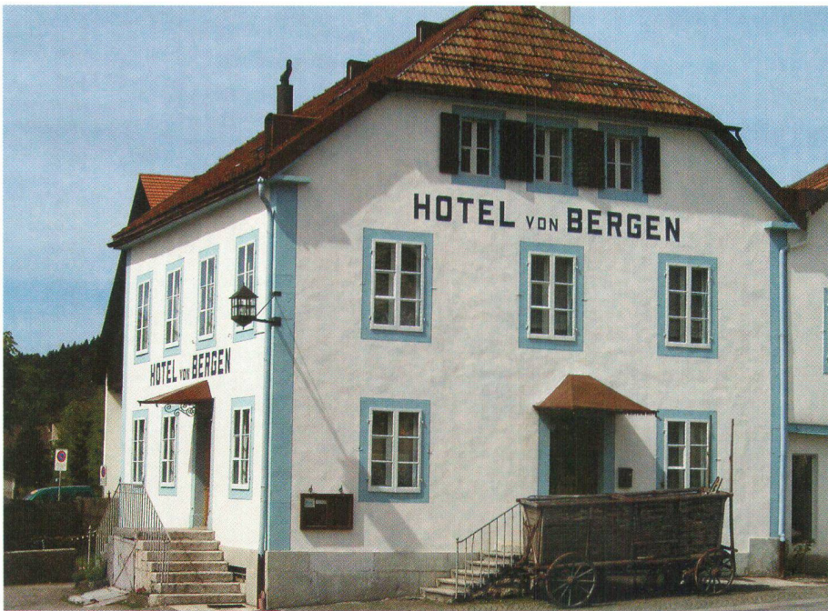
Lorsque l'hôtel fermé fut mis en vente, Evelyne Bühler en fit l'acquisition, le remit en état et le fit renaître (photo Ps)
