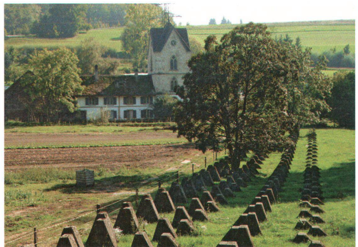
Die Sperre von Löwenberg – eine der als schutzwürdig erachteten und inventarisierten Militäranlagen (Bild VBS) La position de barrage du Löwenberg – l'un des ouvrages militaires dignes de protection qui ont été inventoriés (photos DDPS)
