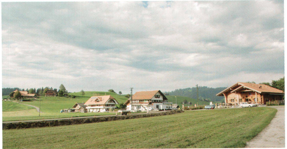
Die Wohnbauten in Rundholz nach nordamerikanischem Vorbild sind mit ihren wuchtigen Dimensionen Fremdkörper in der gebauten Umgebung (Bild SHS) Les maisons en rondins inspirées du style nord-américain, avec leurs formes massives, font l'effet de corps étrangers dans le paysage bâti suisse (photo Patrimoine suisse)
