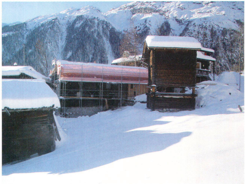
Das Huberhaus im Dezember 2007 während der Renovation (Bild SHS)
