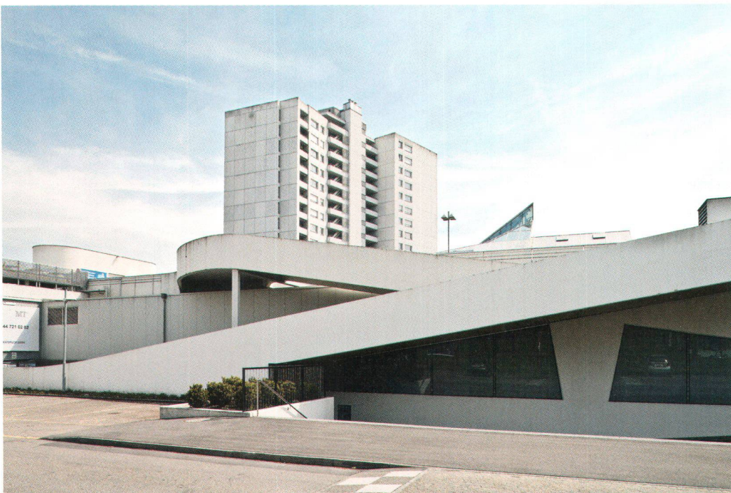
Von der Stadt aus gesehen ist das Hochhaus ein Teil der Betonlandschaft im Schönbühl ... (Bild Mario Kunz)
