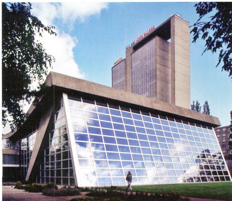
Bienne, Palais des Congrès. Arch. Max Schlup, 1961-1966. Restauration soignée par l'architecte Rolf Mühlethaler (Rolf A. Stähli)
