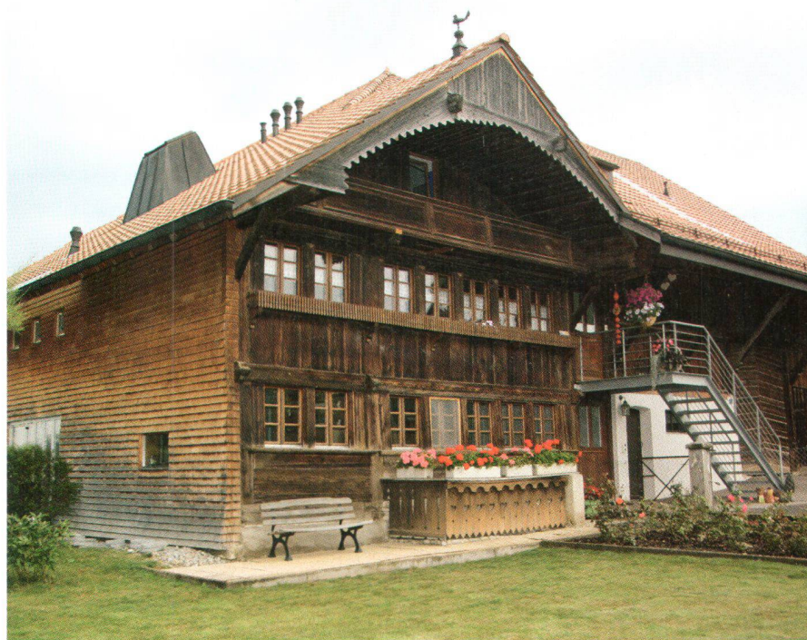
Dans l'ancienne habitation, un nouveau logement en duplex a été aménagé au-dessus de l'appartement du rez-de-chaussée. L'héritage architectural a pu être préservé sans investissement pharaonique (photo C. Crausaz)
