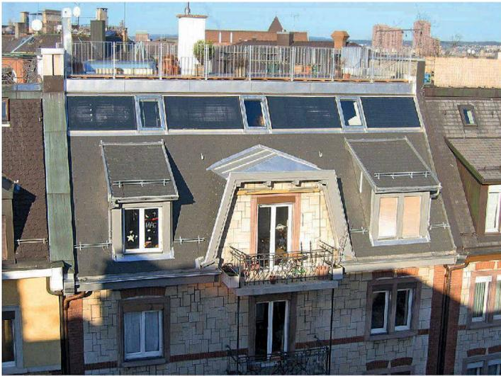
**Sorgfältig ins Dach eingefügte Solaranlage zur Warmwasseraufbereitung in Zürich**
