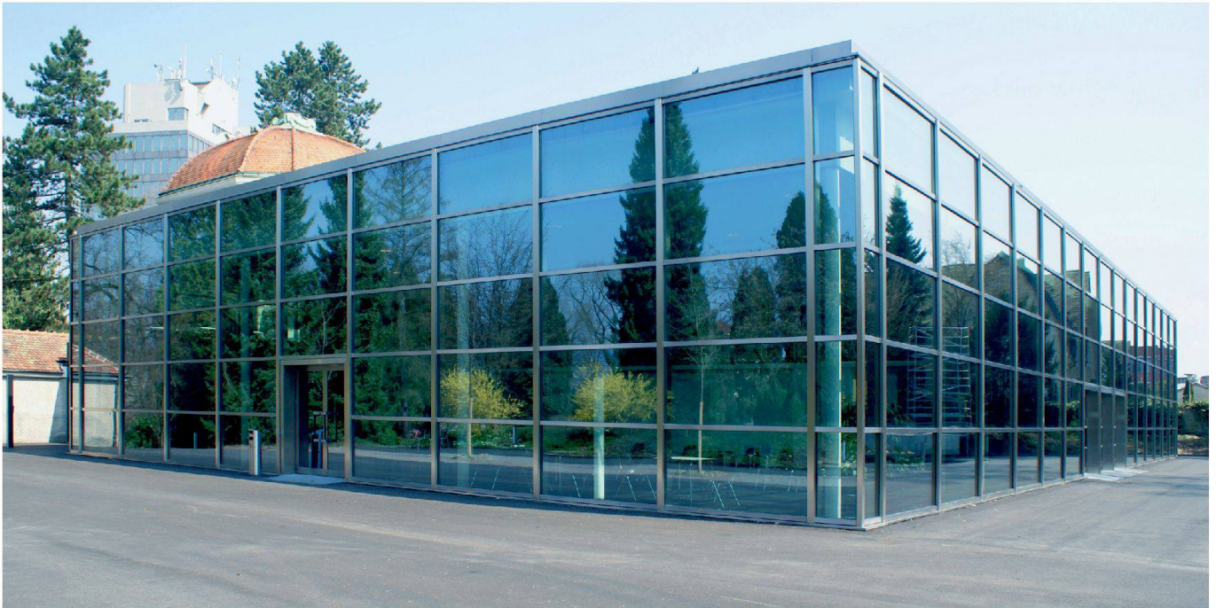
Die renovierte Abdankungshalle von 1968. Im Hintergrund die Kuppel des alten Krematoriums von 1912 (Bild Nicolas Contesse)
