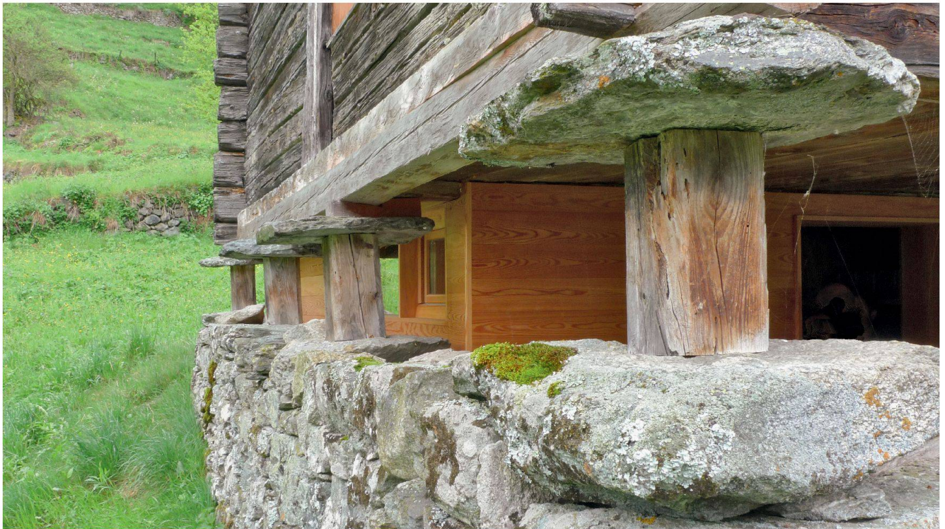
Fachgerecht erhaltenes Gebäude mit neuer Nutzung (Stadel bei Sarreyer/Bagnes). (Bild Werner Bellwald)
