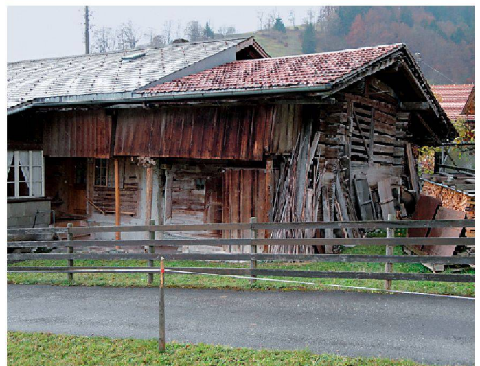
Construction en 1705 des étables et du grenier à foin. (photo Hans-Ruedi Roth)
