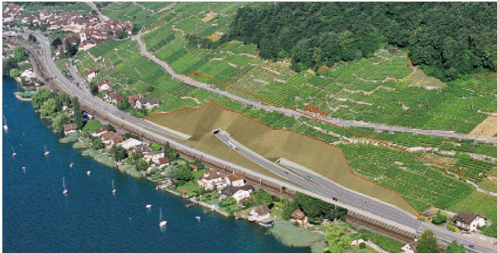
Blick auf das Projekt Twanntunnel, Portal und Halbanschluss Ost. (Visualisierung BHS, SL, Netzwerk Bielersee)
