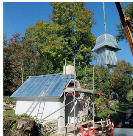
L'oratoire avant la restauration (à gauche). La pose du clocher en octobre 2011 (à droite)
