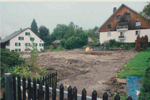
Abstrich: Auf dem Bauplatz im Zentrum von Birchwil stand bis vor wenigen Tagen ein Bauernhaus aus dem Jahre 1550.
