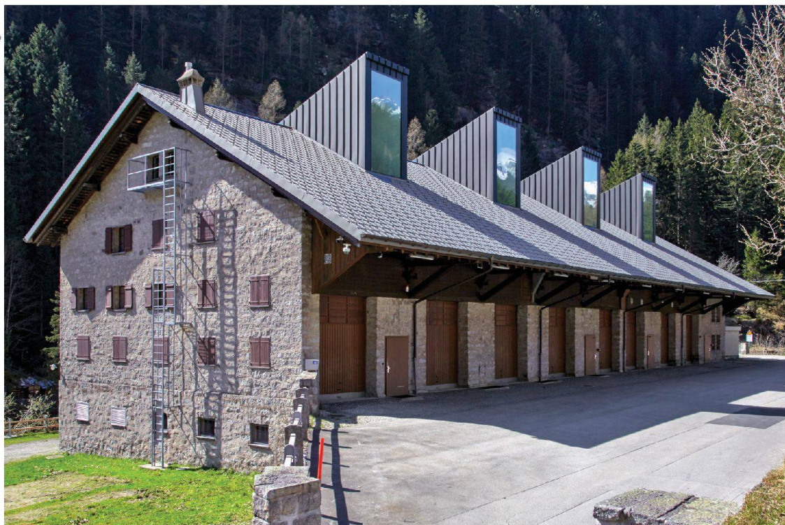
Das vom Büro Burkhalter Sumi Architekten umgebaute ehemalige Zeughaus in Göschenen
