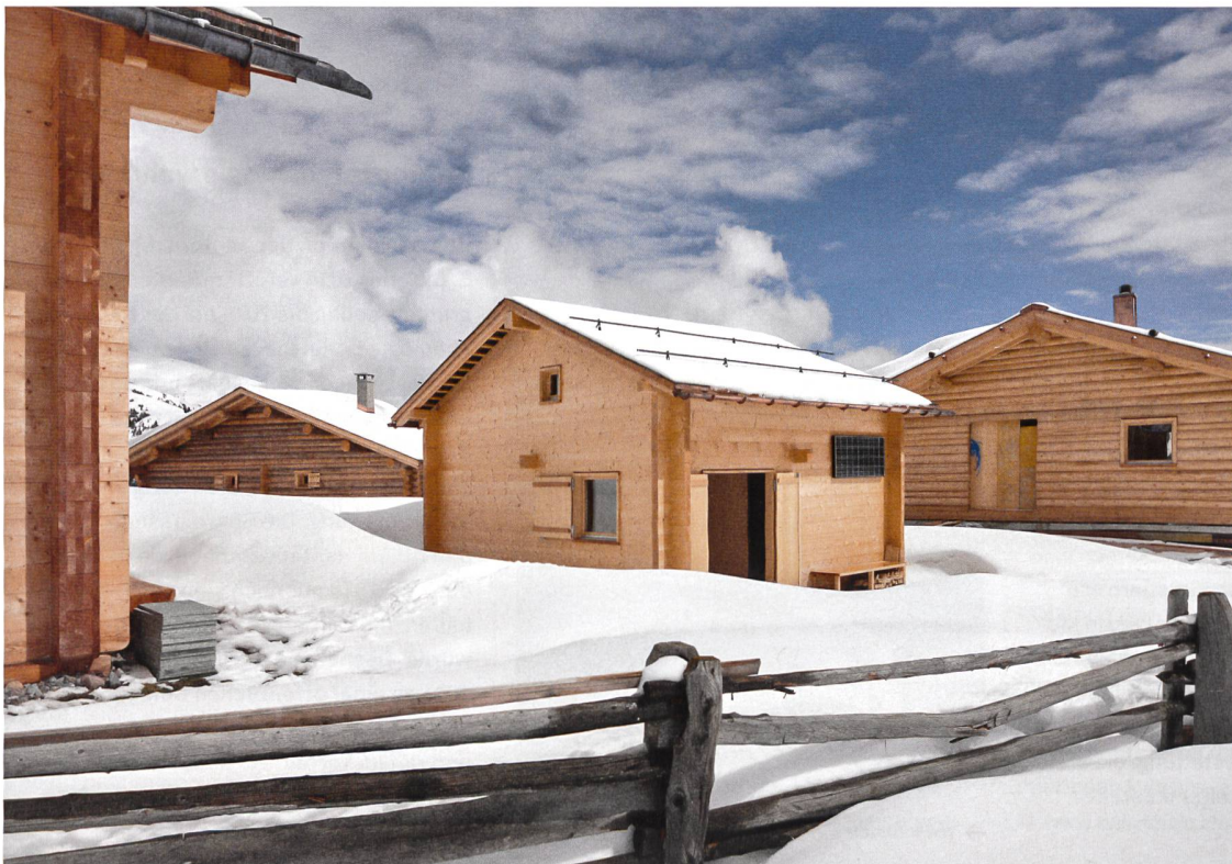
Das neue Holzhaus vom Architekturbüro Bearth und Deplazes auf der Wiesner Alp
