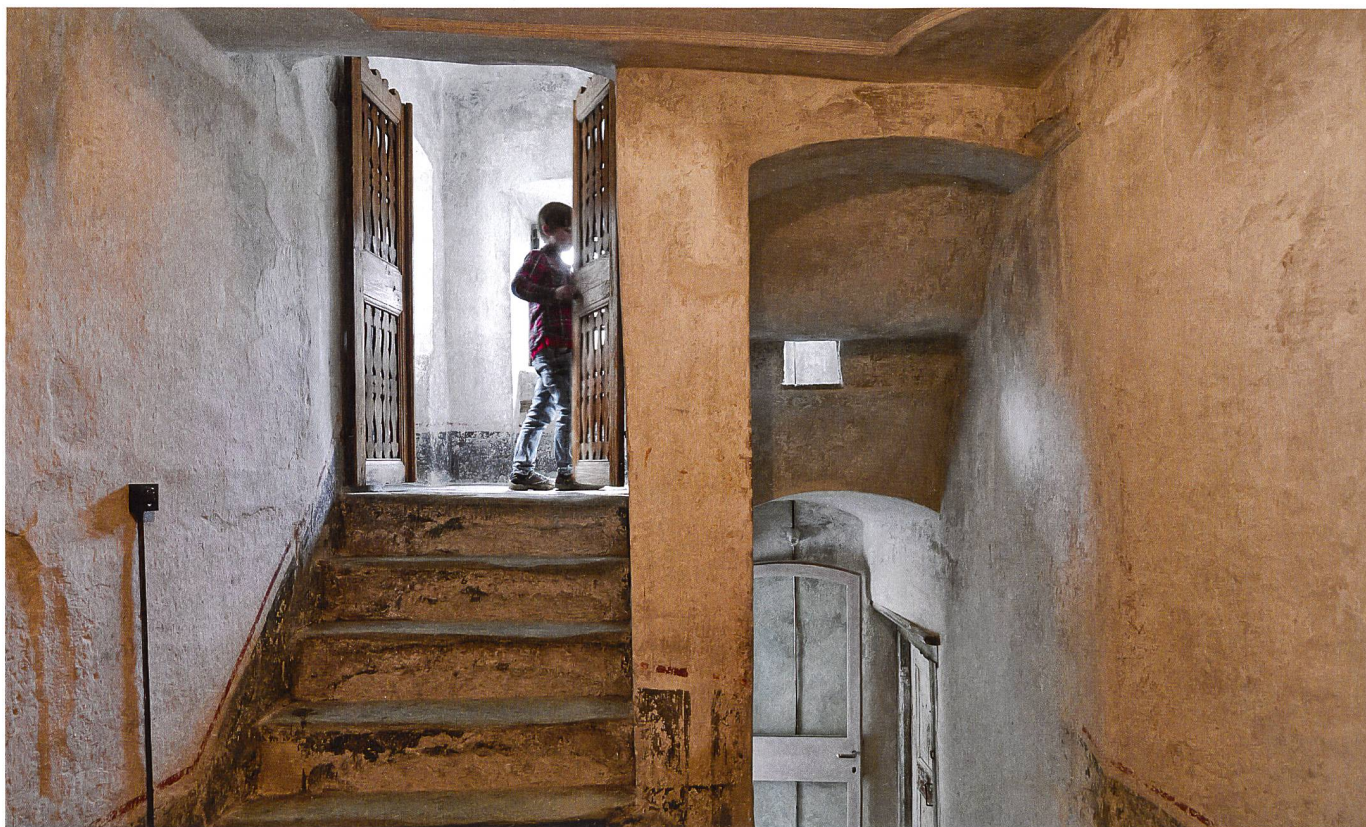
Remettre en état au lieu de remplacer: le crépi de la cage d'escalier de la Türalihus a été restauré dans les règles de l'art. Instandstellen statt ersetzen: Der Verputz im Treppenhaus des Türalihus in Valendas wurde aufwendig restauriert.
