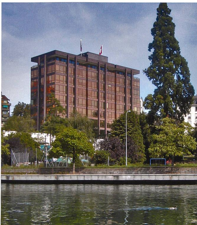
gré son aspect métallique, la structure porteuse est en béton: servant de coffrage lors de la construction, des éléments de tôle d'acier peints en brun constituent le revêtement des piliers et des têtes de dalles. Logiquement, l'acier a été choisi pour la structure de l'étage supplémentaire. Fallait-il exprimer la différence structurelle entre le neuf et l'existant? Entre l'acier et le béton? Affiner les piliers du
