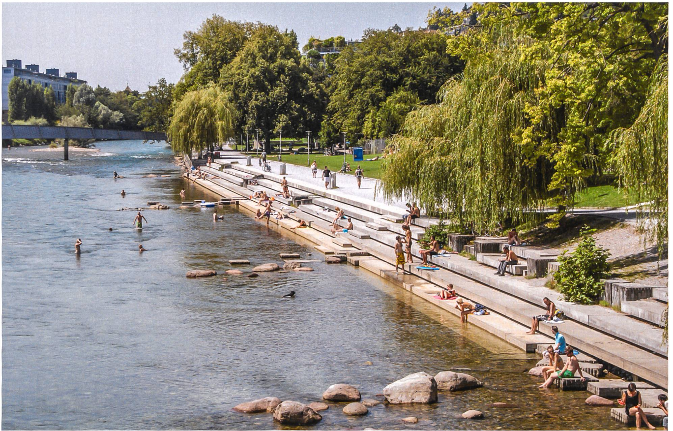
Le parc de Wipkingen, Zurich: une promenade a été aménagée en bordure de l'eau à la faveur des travaux d'assainissement.
