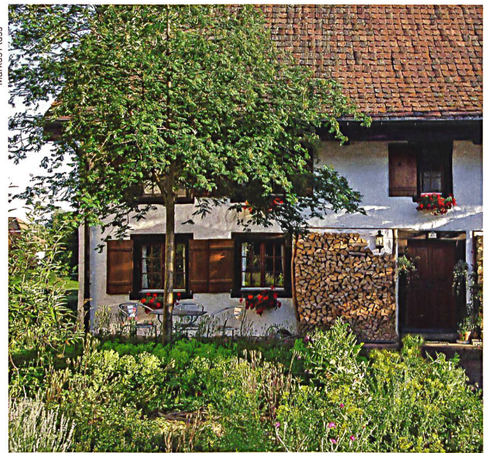
Ferme «Bauernhaus Baudenkmal» (1499) à Ramsen (SH) Bauernhaus Baudenkmal, Ramsen SH (1499)
