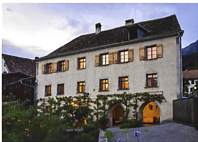
Der linke Hausteil mit Torkel stammt aus den Jahren um 1720. Im rechten Hausteil hinter der um 1780 errichteten Arkade mit aufgehenden Geschossen schlummert der spätmittelalterliche Ursprungsbau.
