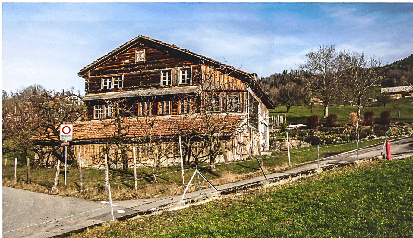
Das Holzhaus in Steinen SZ im Januar 2018 – einer der ersten Fälle auf der neuen Roten Liste des Schweizer Heimatschutzes La maison médiévale de Steinen (SZ) en janvier 2018 – un des premiers objets de la nouvelle Liste rouge de Patrimoine suisse
