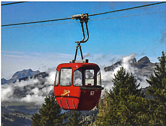
Les Diablerets–Isenau VD: Die Gondeln aus den 1970er-Jahren waren bis Ende April 2017 in Betrieb. Eine Ersatzbahn ist geplant.
