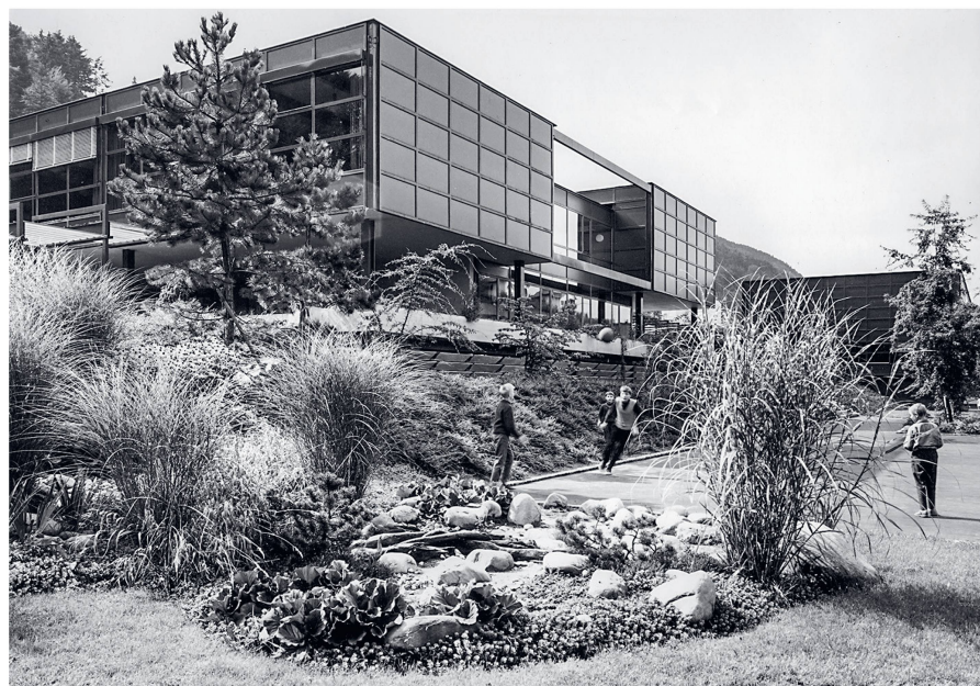
Die Schulanlage Grenzhof in Luzern ist auch auf der Roten Liste des Schweizer Heimatschutzes aufgeführt (vgl. Seite 38).
