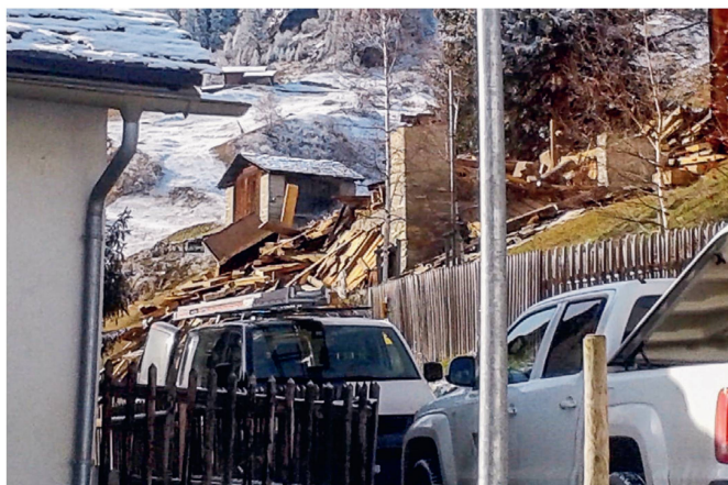
Das Hansjörisch Hus nach dem Abbruch, Ende November 2018 La «Hansjörisch Hus» après sa démolition, fin novembre 2018
