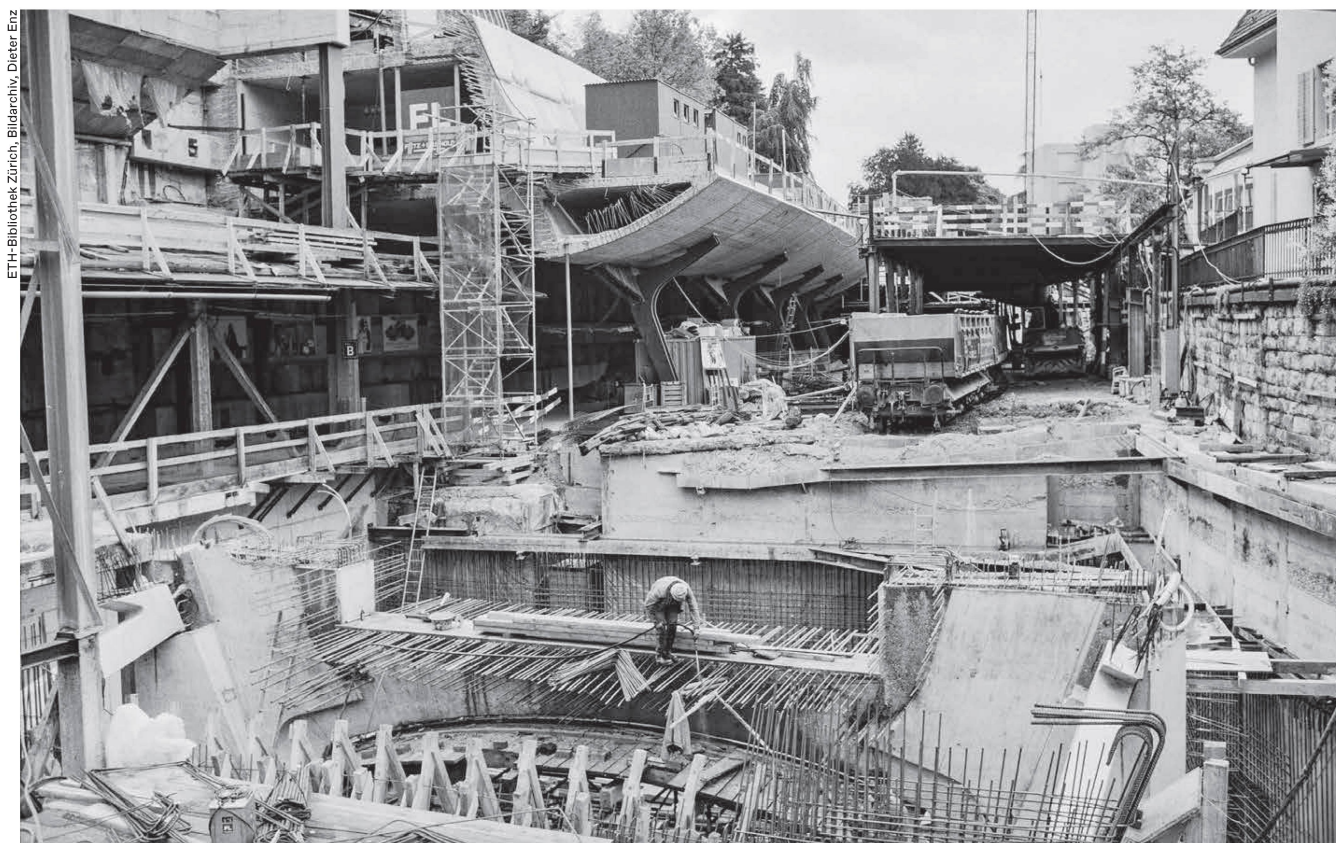
Die Baustelle des Bahnhofs Stadelhofen im Juli 1988 Le chantier de la gare de Stadelhofen en juillet 1988
