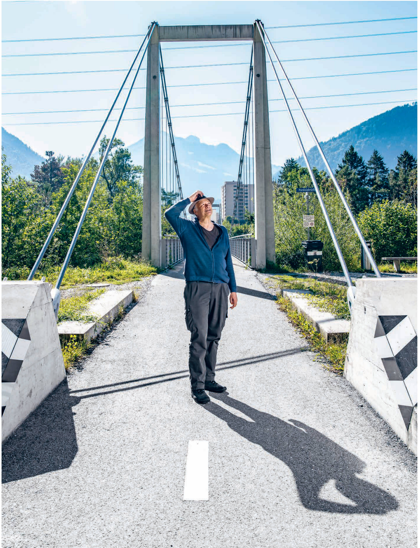
Der Bauingenieur Jürg Konzett vor einem seiner jüngeren Werke, der Rad- und Fussgängerbrücke «Pardisla» (2016/2017), die Chur und Haldenstein (GR) verbindet. L'ingénieur civil Jürg Konzett devant l'une de ses dernières créations, le pont pour les piétons et les cyclistes «Pardisla» (2016/2017), qui relie Coire et Haldenstein (GR).
