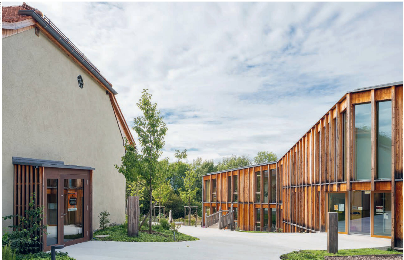
Achevée en 2020, la crèche Le Tournesol, à Renens, est construite en bois, à l'exception des fondations et de la cage d'ascenseur. Die 2020 fertiggestellte Kindertagesstätte Le Tournesol in Renens besteht mit Ausnahme des Sockels und des Liftkerns aus Holz.
