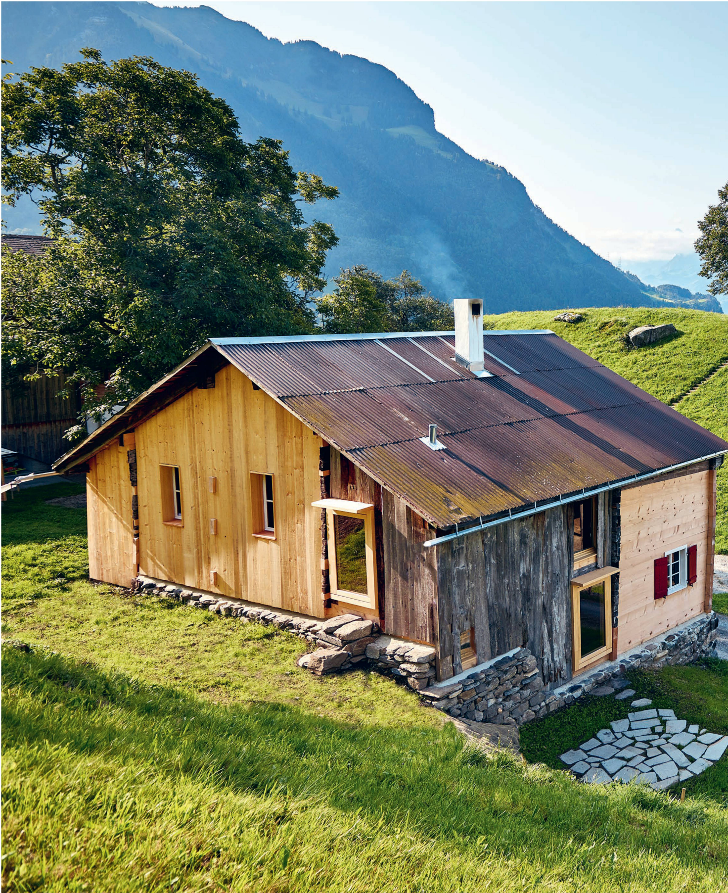
Das Haus Tannen in Morschach (SZ) 2017, kurz nach der Eröffnung La Haus Tannen à Morschach (SZ) en 2017, après son ouverture
