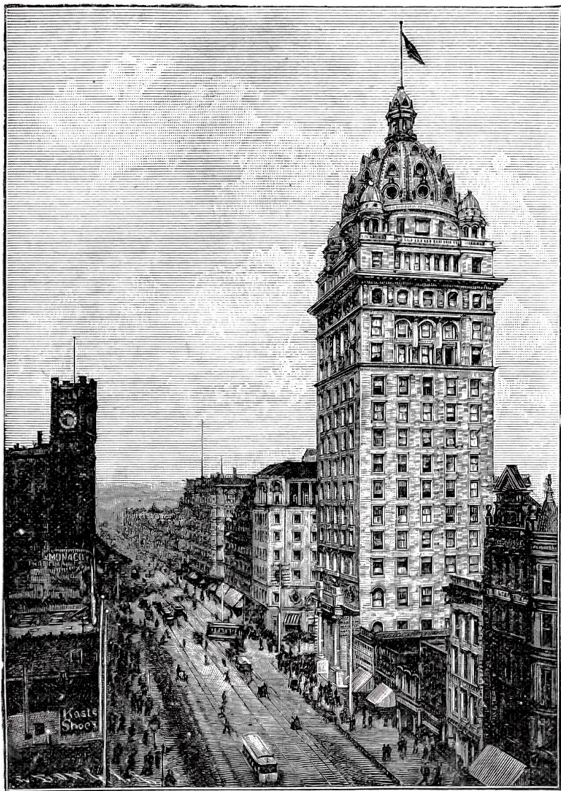
Die Marktstraße mit Call-Gebäude in San Francisco.
