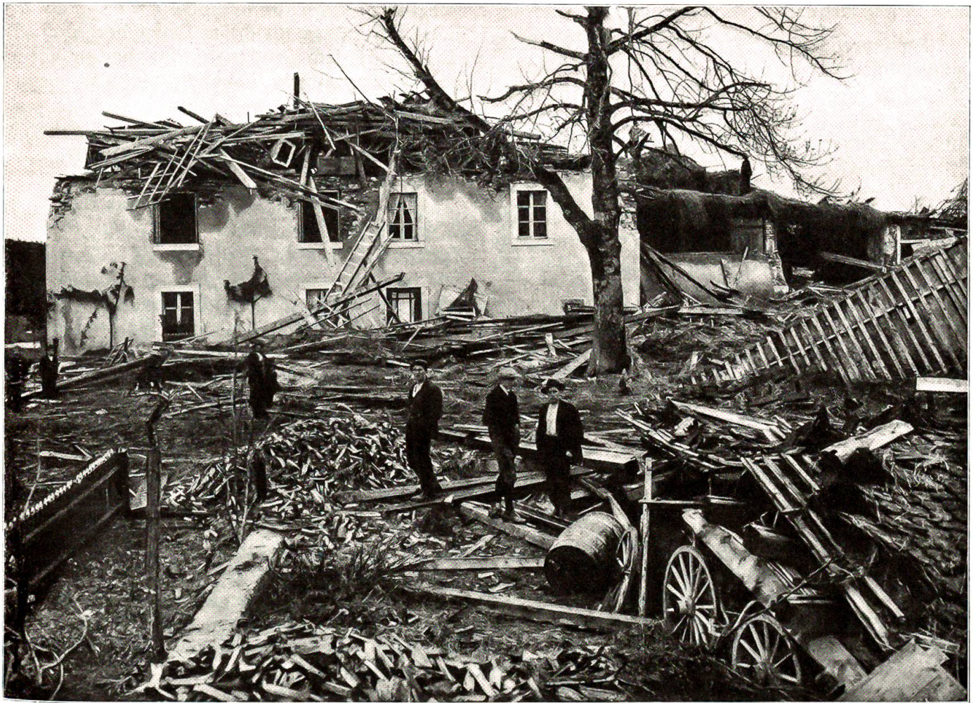
Sturmverheerungen im Jura. Zerstörtes Haus in Chaux-d'Abel.
