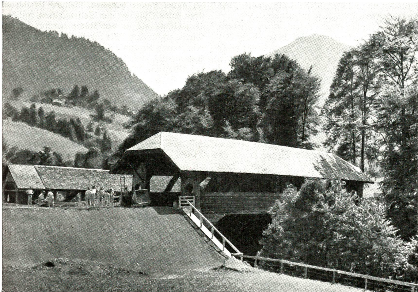
Die höchste Holzbrücke Europas wurde über das Melchaatobel zwischen Flüeli und Kerns neu erstellt
