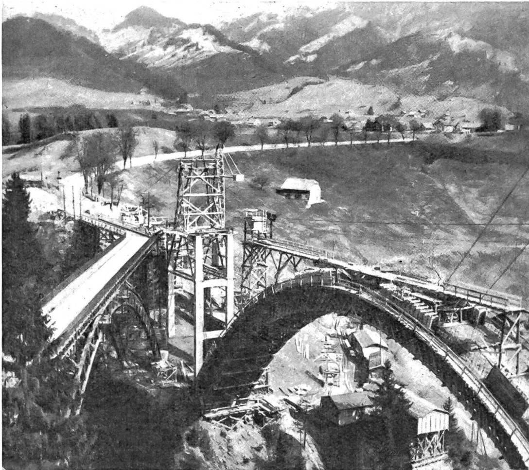
Eine neue Brücke von 160 m Länge und 9 m Breite über das Tal der Javroz im Grenerzerland
