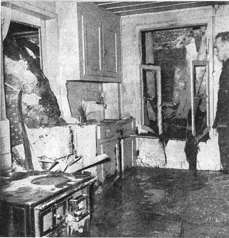
Die Unwetter im Juni 1953. Bei Bärau wurde ein Haus von abrutschenden Erdmassen schwer beschädigt.
