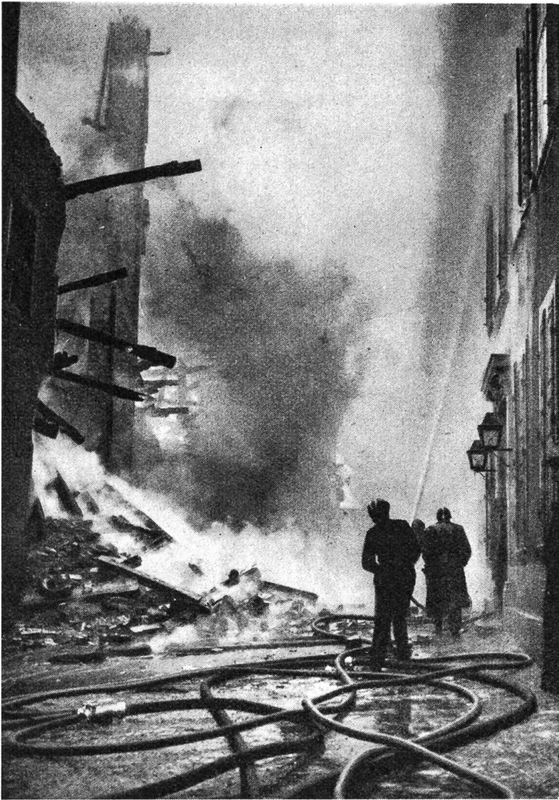
Der Brand eines Lagerhauses am Nadelberg in Basel im Februar 1956 verursachte zwei Millionen Franken Sachschaden. Die grimmige Kälte behinderte die Löscharbeiten in hohem Maße.
