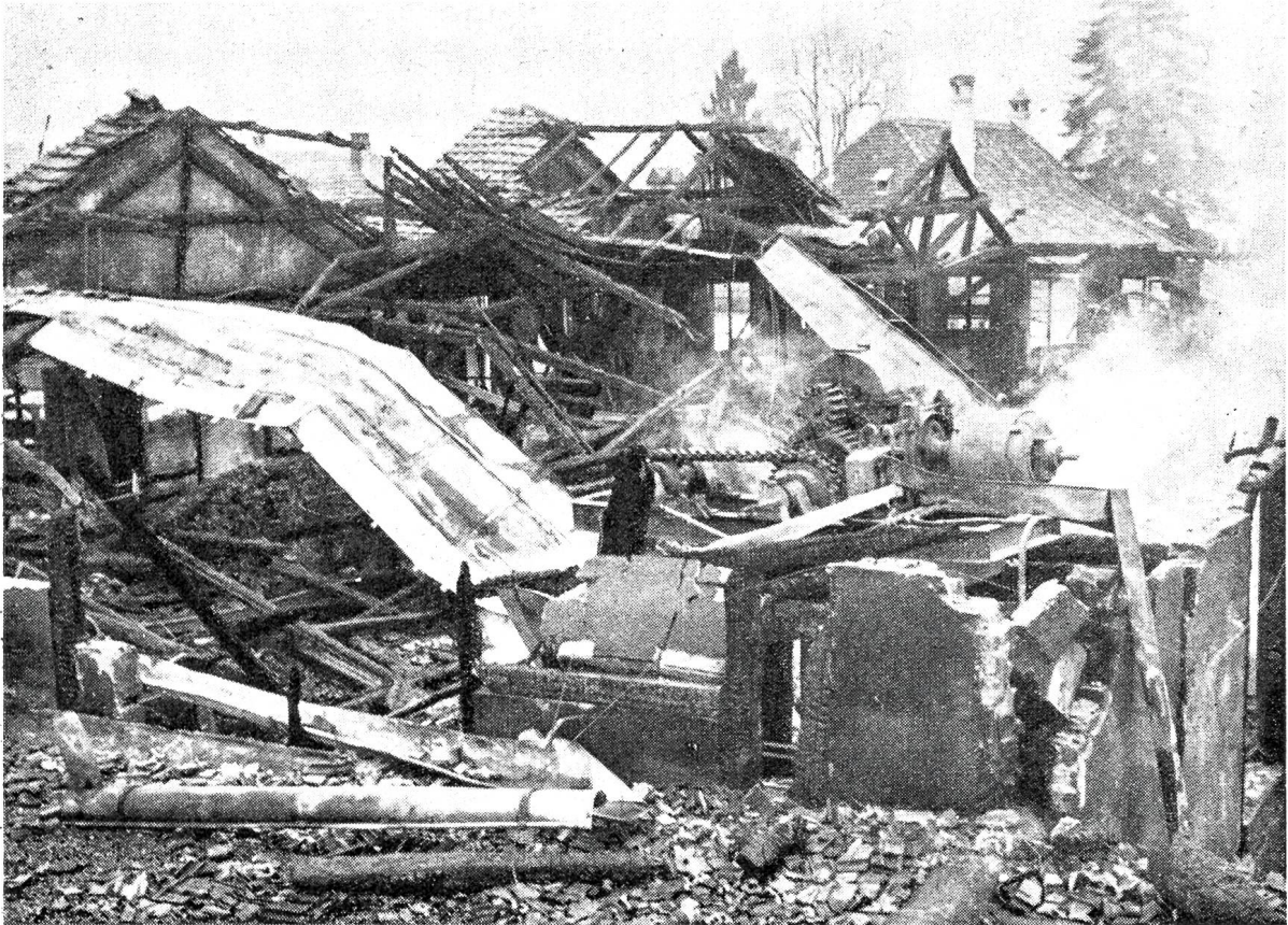
Brand der Ziegelei Pieterlen im Februar 1957. Der Sachschaden belief sich auf rund eine Million Franken.
