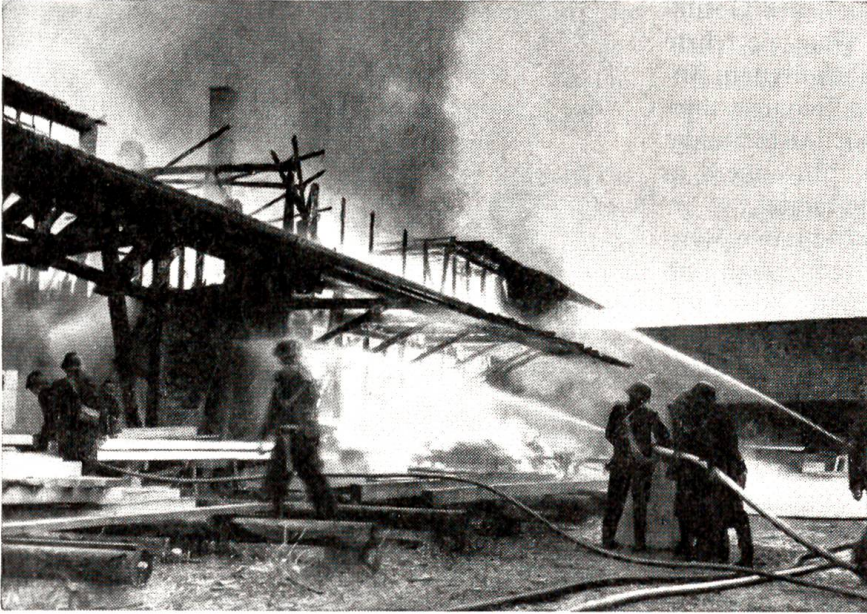
Großbrand in Gümliigen
