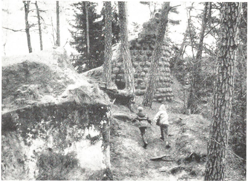
Die Ruine Geristein im heutigen Zustand Foto H. Schneiter, Bern
