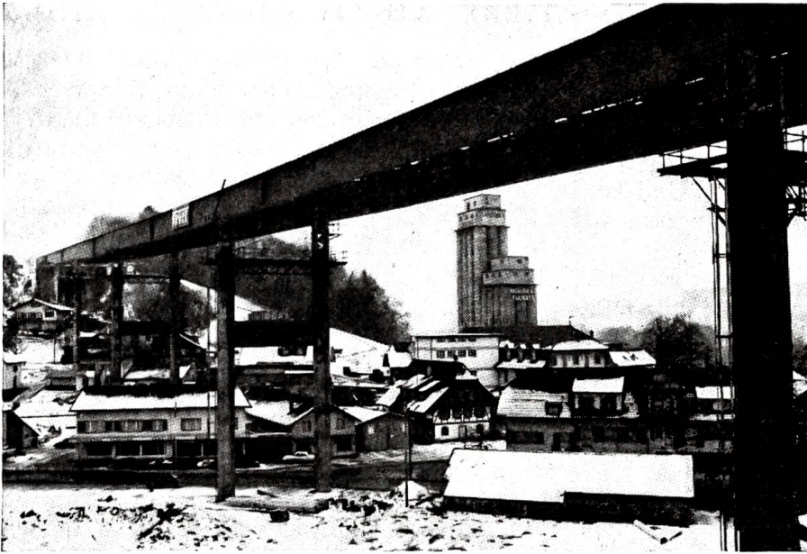
Autobahn-Viadukt über dem Dorf Flamatt im Bau
