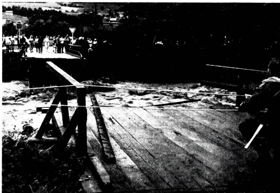
Unwetterschaden bei Steffisburg
