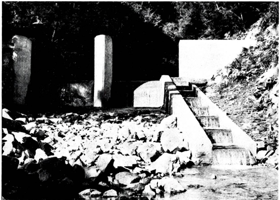
Neue Fischtreppe in der Vedeggio im Tessin
