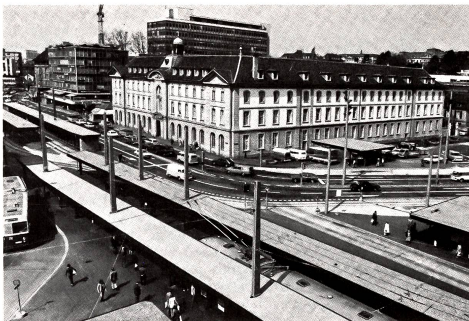
Burgerspital renoviert – Bubenberplatz verunstaltet
