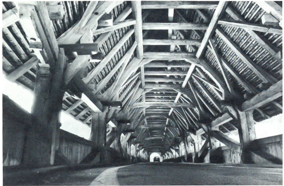
Renovation an der Neubrücke Die hölzerne Fahrbahnplatte und einzelne Träger der prachtvollen alten Brücke mussten ersetzt werden. Photo Hansueli Trachsel, Bern
