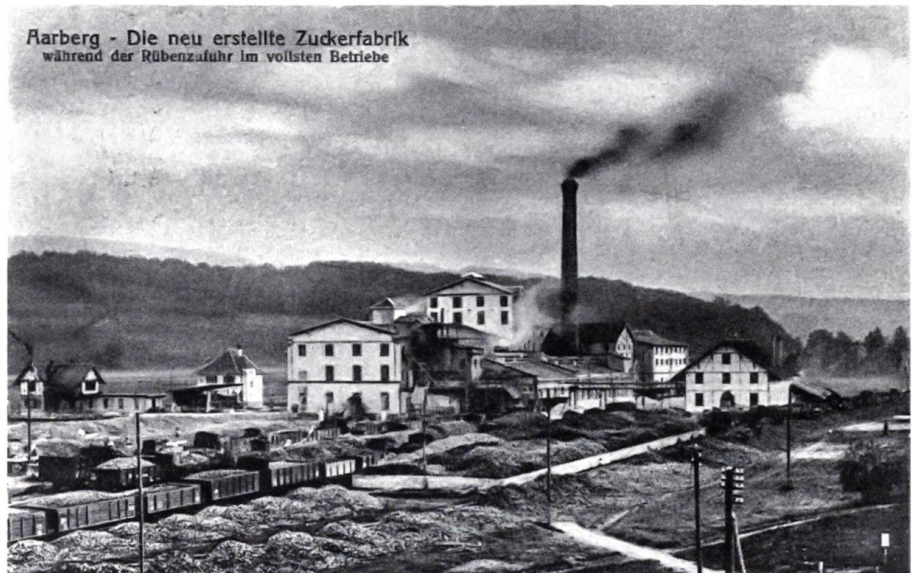
Aarberg – Die neu erstellte Zuckerfabrik Postkarte aus dem Jahre 1913. Die Foto wurde kurz nach der Eröffnung der Zuckerfabrik aufgenommen. (Kunstdenkmäler des Kantons Bern, Photo Gerhard Howald, Kirchlindach BE)
