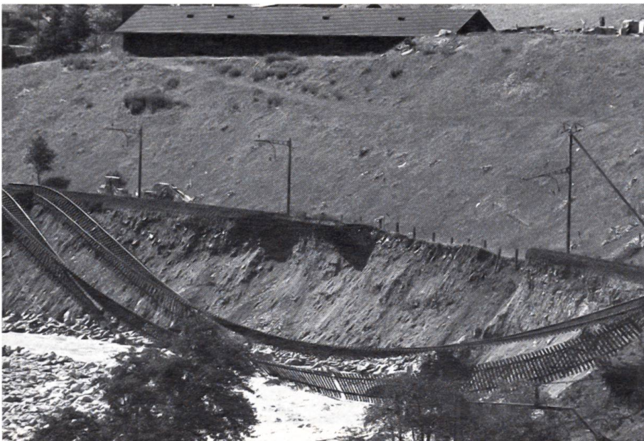
Verheerende Unwetter in der Schweiz Die weggeschwemmte Bahnlinie der Gotthardstrecke bei Gurtneilen. (Photo Keystone-Press, Zürich)
