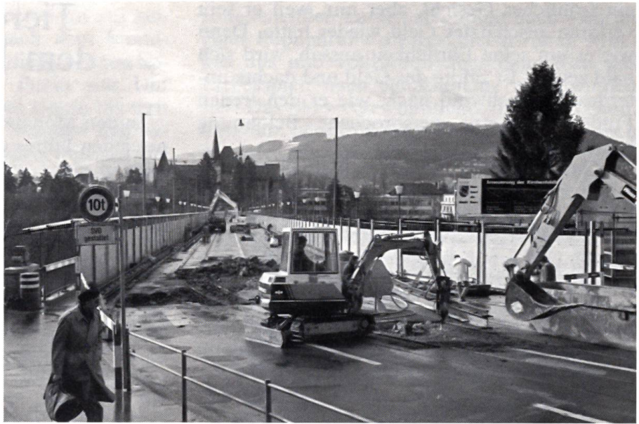
Sanierung der Kirchenfeldbrücke in Bern
