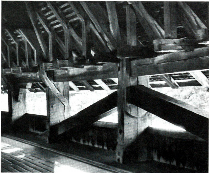
Aarebrücke Wangen a. d. A., beeindruckend die wuchtigen Balken im Spreng- und Hängewerk der Brücke (Bildvorlage: Ortssammlung Wangen a. d. A.)
