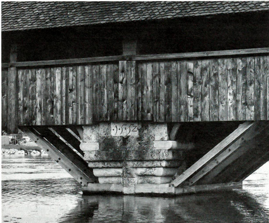
Aarebrücke Wangen a. d. A., westlicher Brückenpfeiler von 1552 (Inventarisierung der bernischen Kunstdenkmäler, Bern, Photo G. Howald, Kirchlindach)
