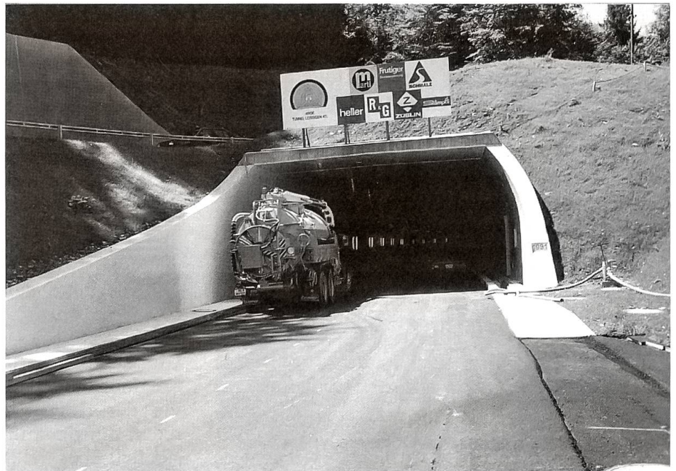
Umfahrung von Leissigen vor seiner Fertigstellung Das Bauwerk wurde Ende Juni 1994 dem Verkehr übergeben. Unser Bild zeigt das Tunnelportal auf der Ostseite. (Foto: Fritz Lörtscher, Bern)
