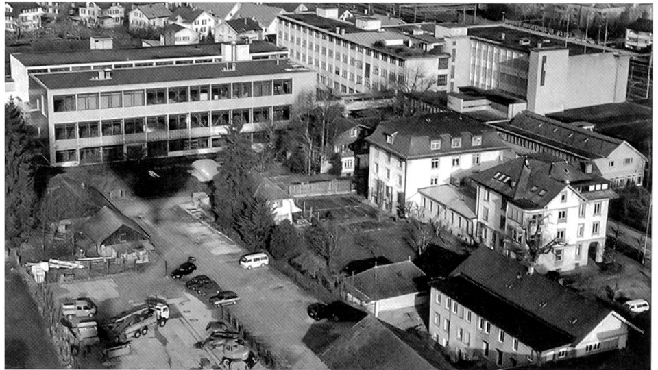
Ansicht der heutigen Fabrikanlage in der Nähe des Bahnhofs Burgdorf
